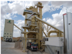
Asfaltos y Hormigones
